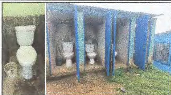
Foto 2: Sustrucion de accesorios inodoro (contrallave, tubo de abasto y tanque).
