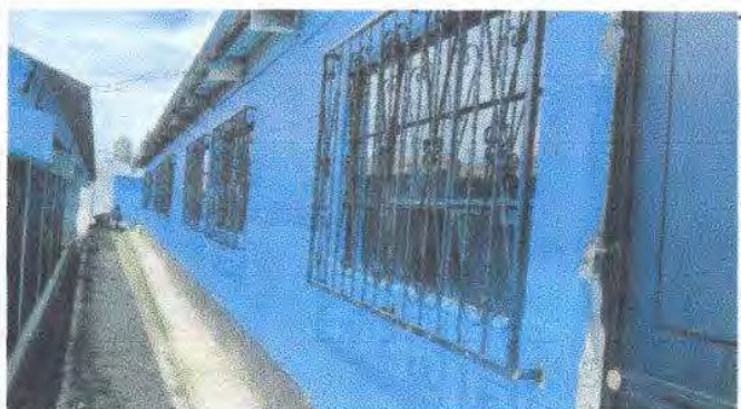
Foto 3: Sustitución de vidrios
