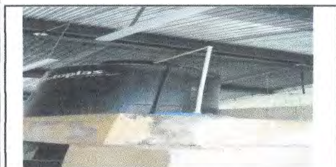
Foto 5: Sustitución de accesorios de depósito de agua
