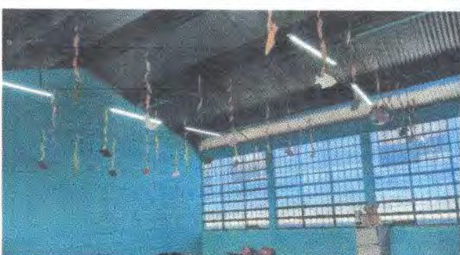
Foto 4: Sustitución de ducto eléctrico más accesorios
