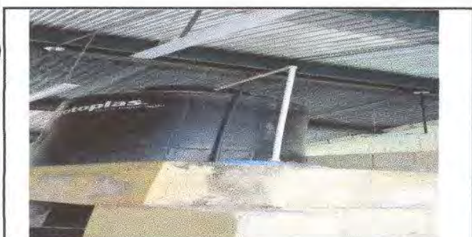
Foto 5: Sustrucion de accesorios de deposito de agua
