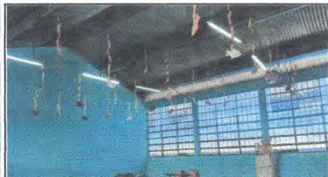
Foto 9: Sustitución de 33 metros de cable por lámparas led, apagadores y tomacorrientes.
