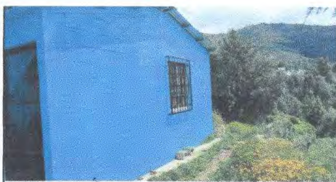
Foto 5: Fabricación e instalación de ventana-balcón de metal
