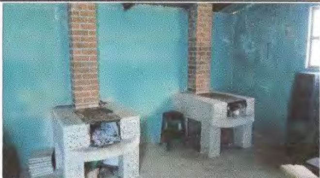
Foto 7: Sustrución de estufa rural (completa) incluye chimenea y plancha de meta
