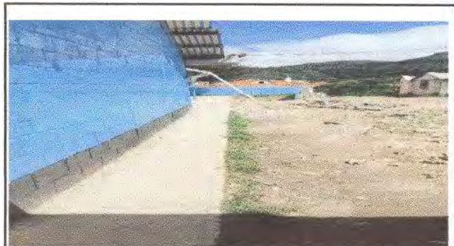
Foto 4: Sustrucion de tubería PVC línea principal de aguas negras
