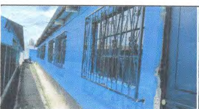
Foto 6: Fabricación e instalación de balcones de hierro en ventanas
